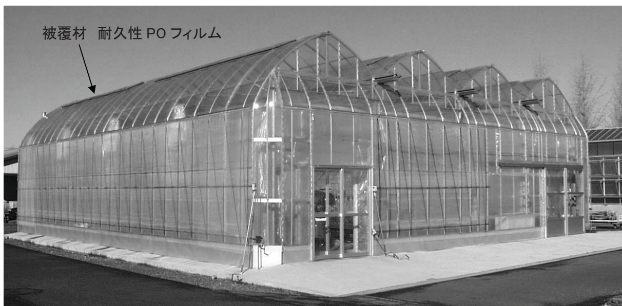
図5 研究所内に建設したメロン超低コストモデル温室の全景 (東西棟)
