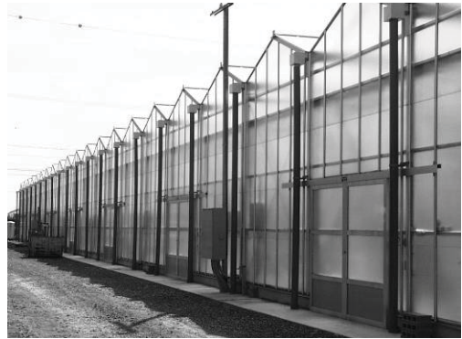
図2 現地に普及しているフェンロー型大規模メロン温室の事例(浜松市)
