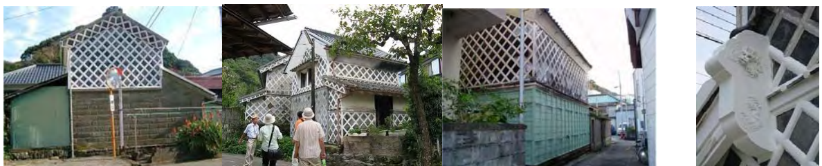
蔵：総海鼠造+伊豆石（下流） 蔵：部分漆喰・海鼠壁（松崎） 蔵：同左+板張り（田子） 鰻絵（松崎）
