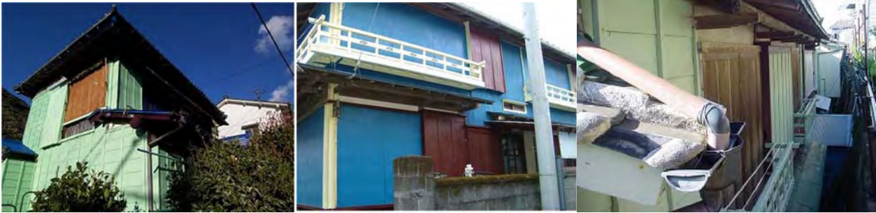
母屋：下見板張り+ペンキ (安良里)
