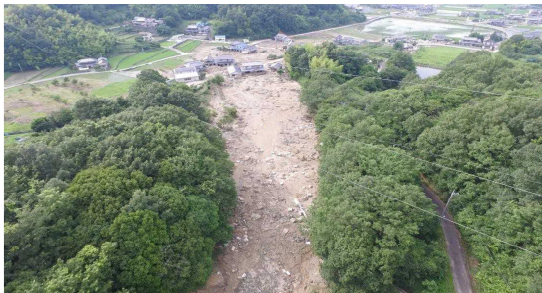
土石流により決壊したため池 (平成30年7月豪雨)
