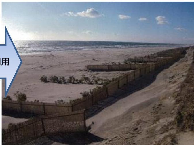
砂丘を造成するため砂を堆積させる堆砂垣に伐採した竹材を利用
