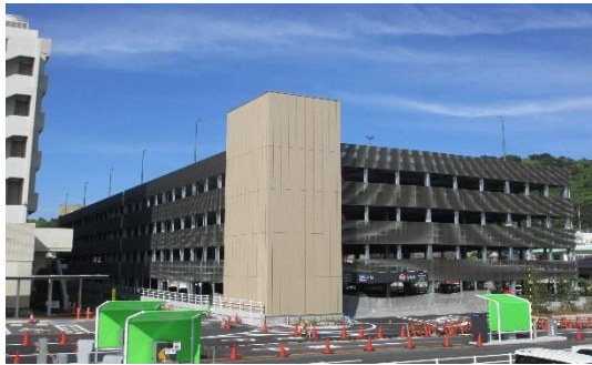
<北立体駐車場>
