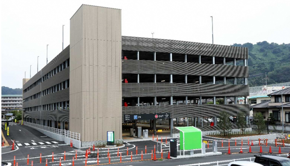
< 北 立 体 駐 車 場 >
