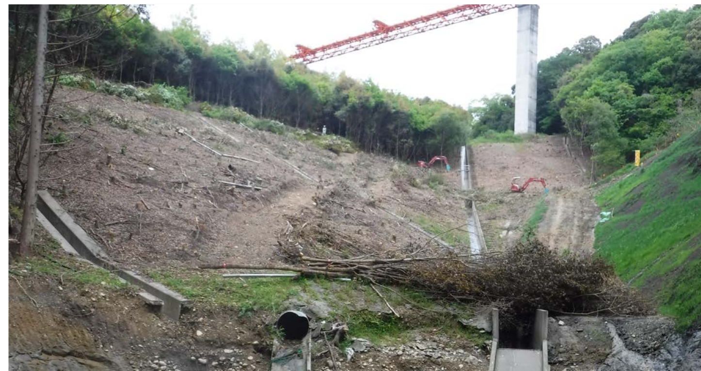
[令和4年4月20日現在の伐採の状況]
