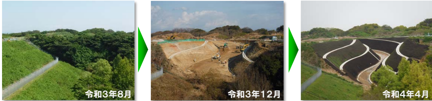
[工事用進入路(上段部)の進捗状況写真]
