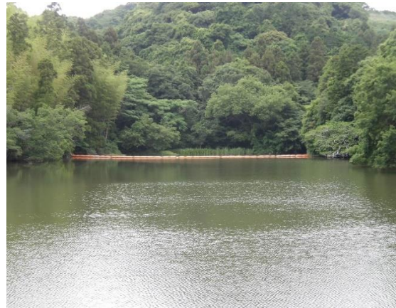
⑰千頭ヶ谷池 シルトフェンス
