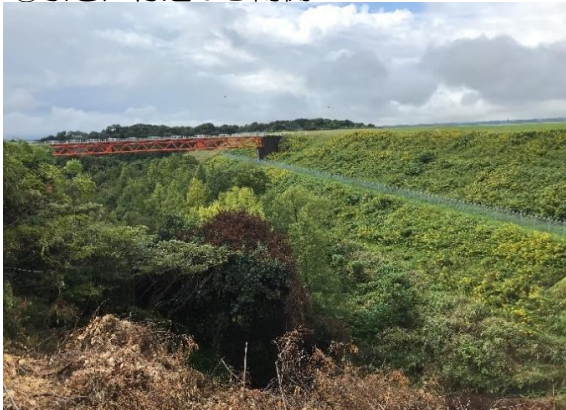
⑮ 引き戸付近から南側
