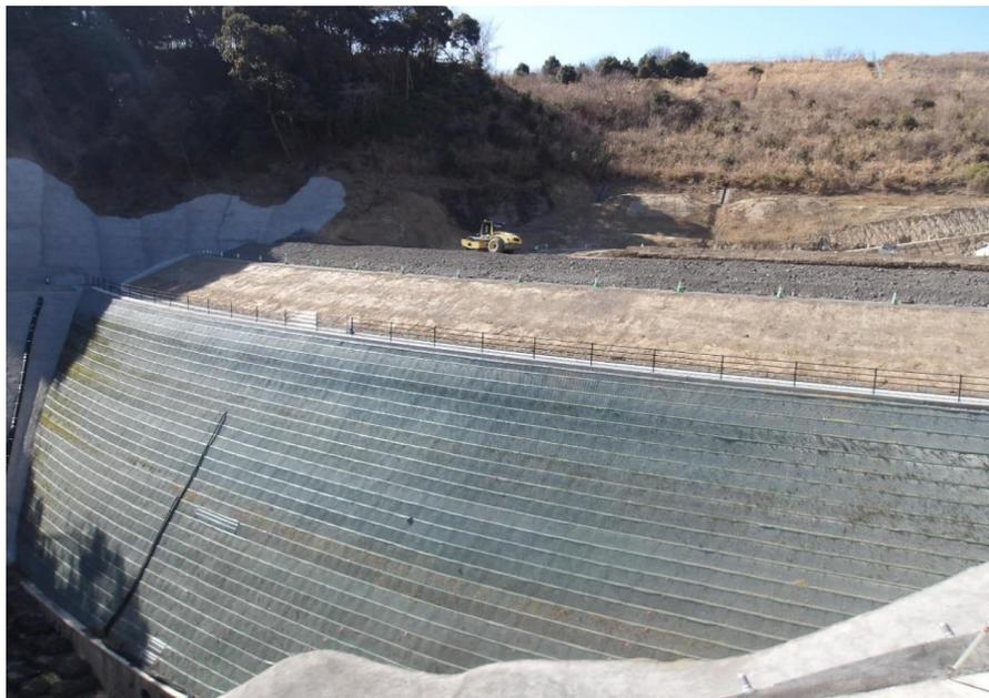
RESA整備工：上載盛土 2 段目施工中
