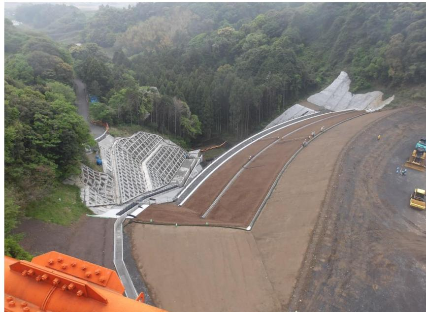
RESA整備工：上載盛土3段目施工中
