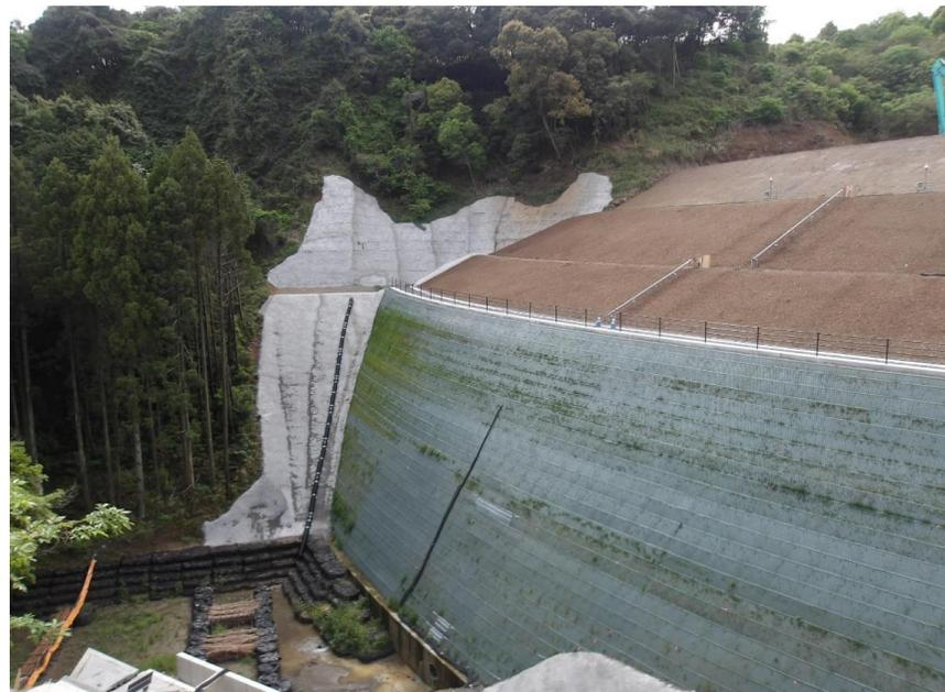
RESA整備工：上載盛土 3 段目施工中
