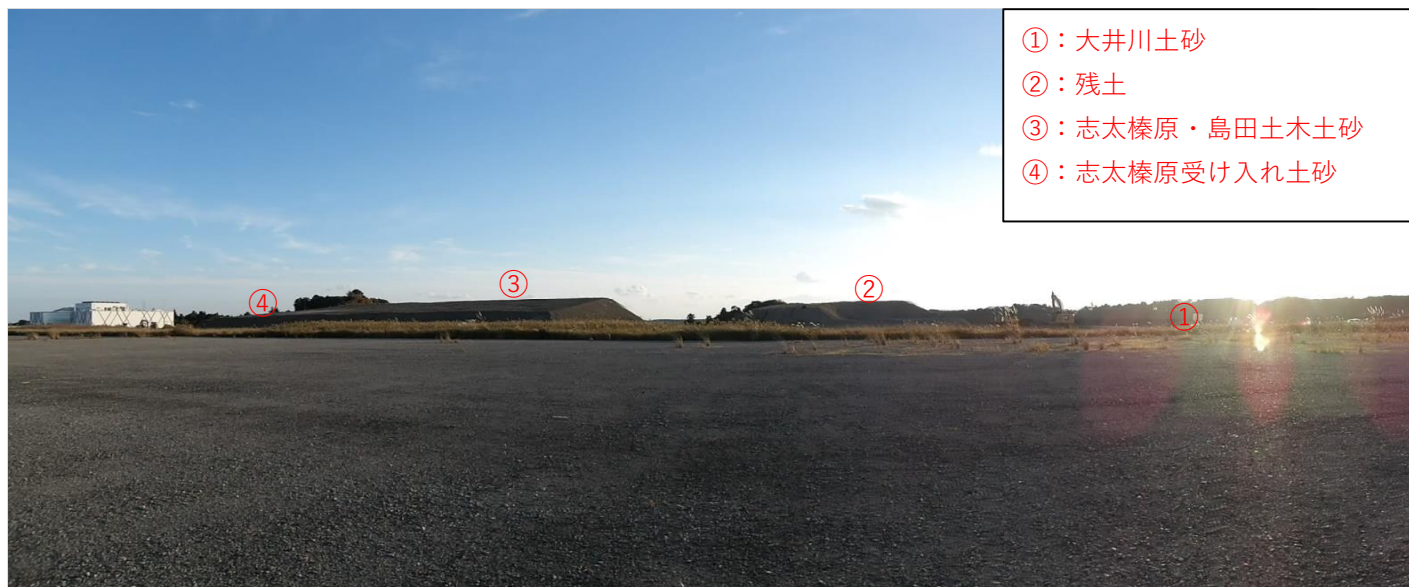
整地工その2：大井川土砂搬入中。
