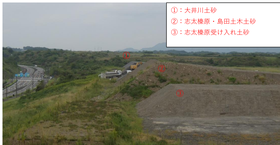
整地工その2：RESA工事現場へ搬出中。
