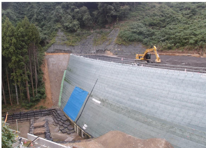
RESA補強盛土工 高さ17.4m（29段）のうち、 高さ16.8m（28段）まで施工済み
