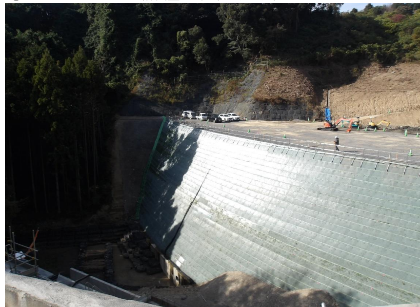
RESA補強盛土工 高さ17.4m（29段）まで施工完了。
