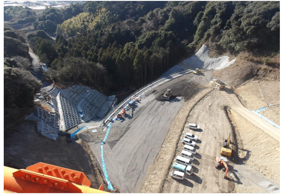
RESA整備工：上載盛土1段目施工中
