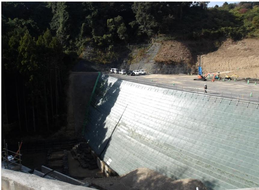
RESA補強盛土工 高さ17.4m (29段) 施工完了
