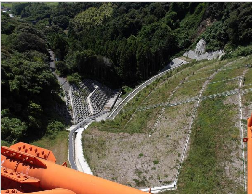
RESA整備工：橋梁上部工撤去中
