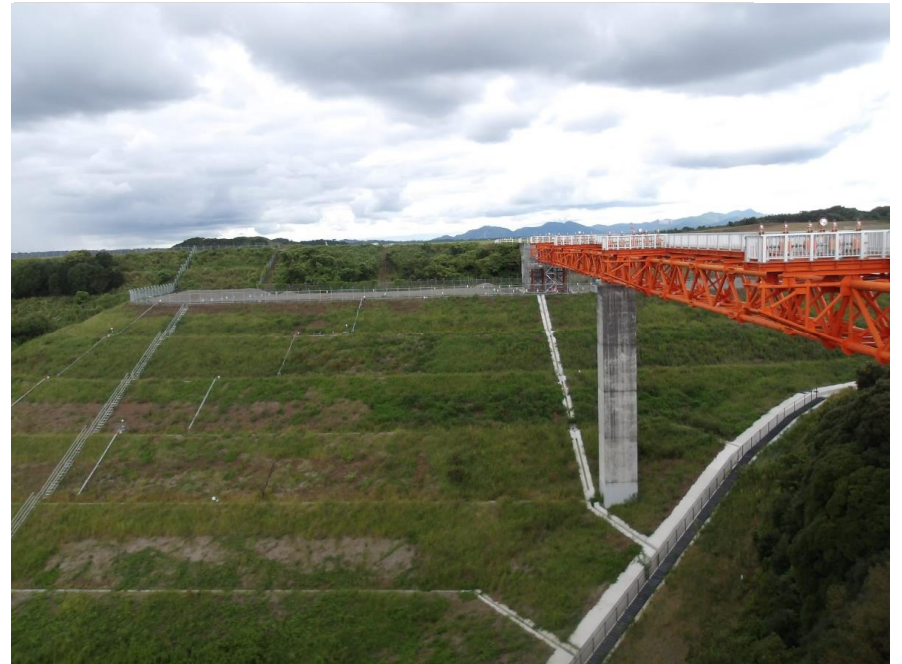
RESA整備工：橋梁上部工施工中
