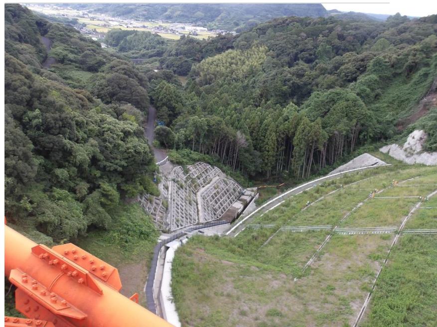
RESA整備工：橋梁上部工施工中
