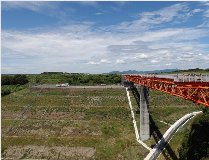
RESA整備工：橋梁上部工撤去中
