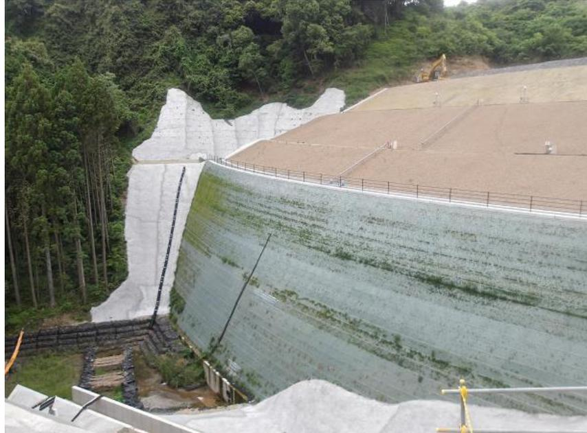
RESA整備工：上載盛土4段目施工中
