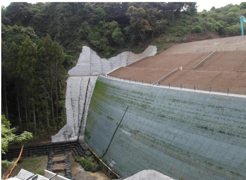
RESA整備工：上載盛土3段目施工中
