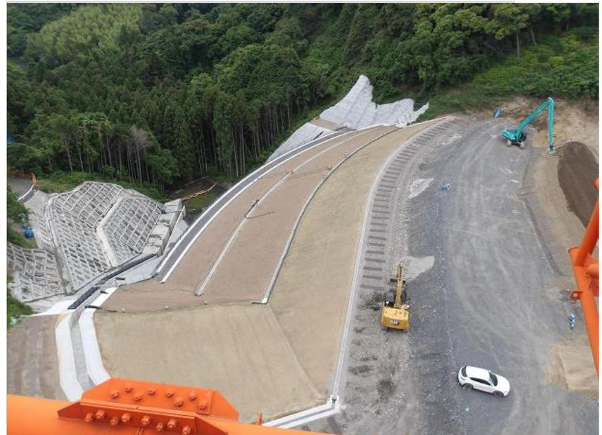
RESA整備工：上載盛土4段目施工中
