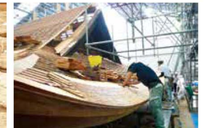
文化財の修理 (磐田市 県指定建造物 府八幡宮楼門)
