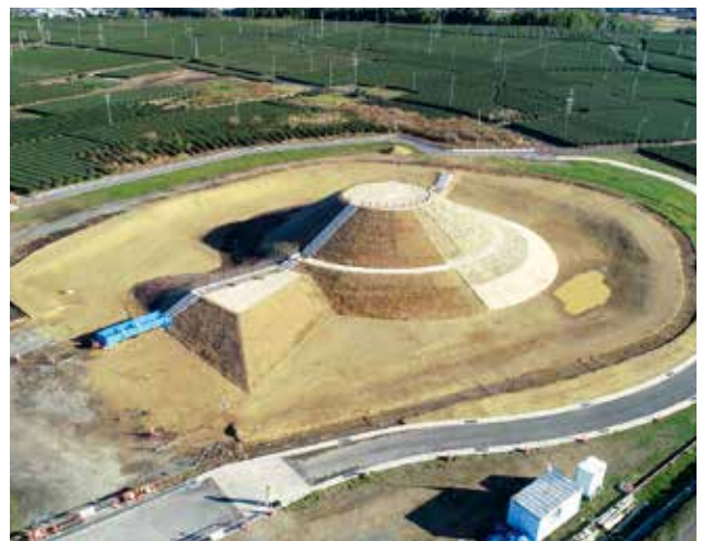
史跡整備中の前方後円墳 吉岡大塚古墳(掛川市 国史跡)
