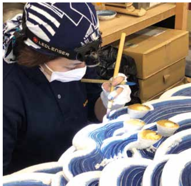
建造物の修理（色彩） 静岡浅間神社（静岡市 国建造物）
