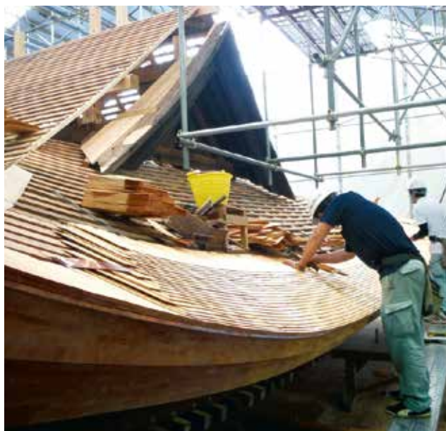
建造物の修理（柿葺の葺き替え） 府八幡宮（磐田市 県建造物）
