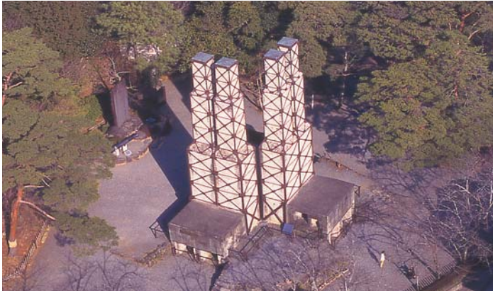
葦山反射炉(写真:伊豆の国市提供)
