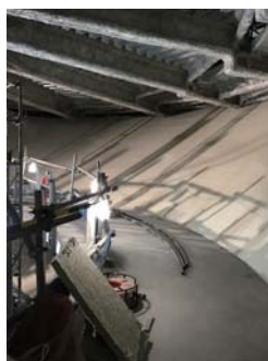
展示棟内の螺旋スロープの内装工事を進めました。
