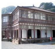
旧鹿児島紡績所技師館
