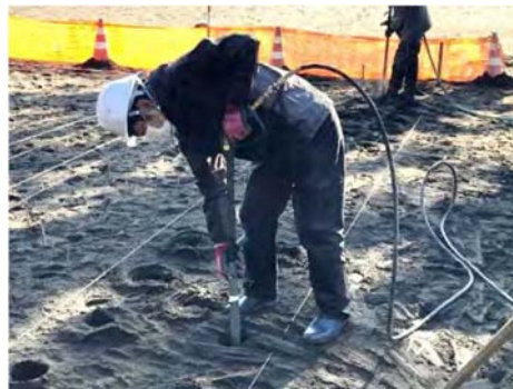
水圧穿孔作業
