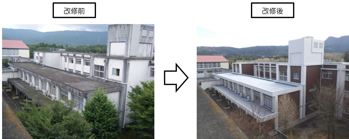
県立小山高等学校管理棟の外壁屋上改修
