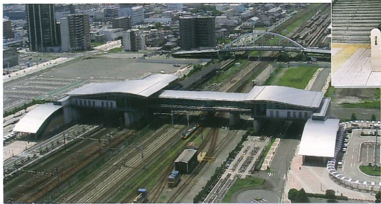
東静岡駅・南北自由通路
