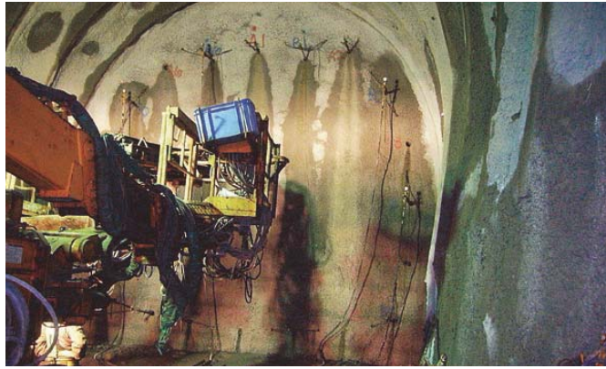
図 5-3-3 薬液注入工の施工例
