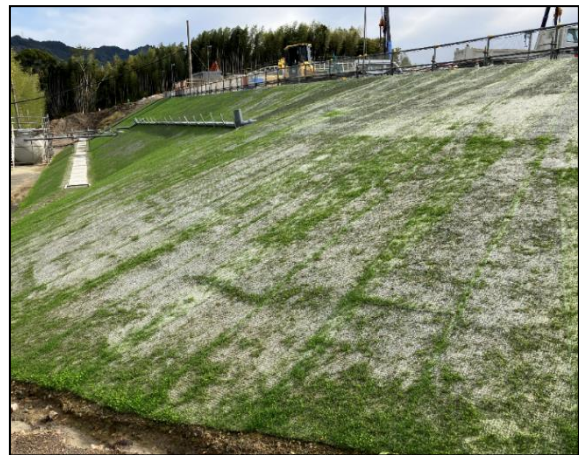
写真4 植生シートの施工
