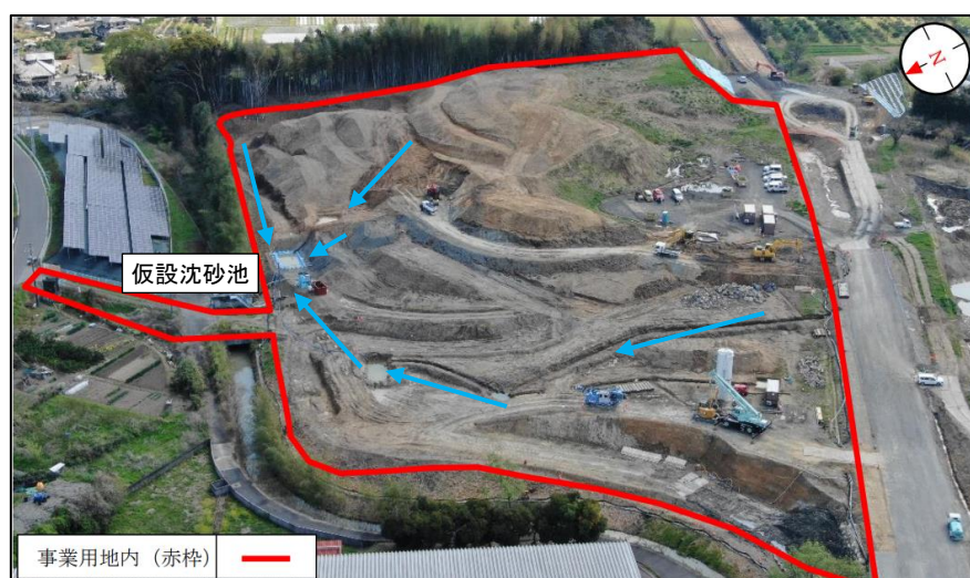
写真 1 仮設沈砂池及び水の流れ（令和 5 年 3 月）
