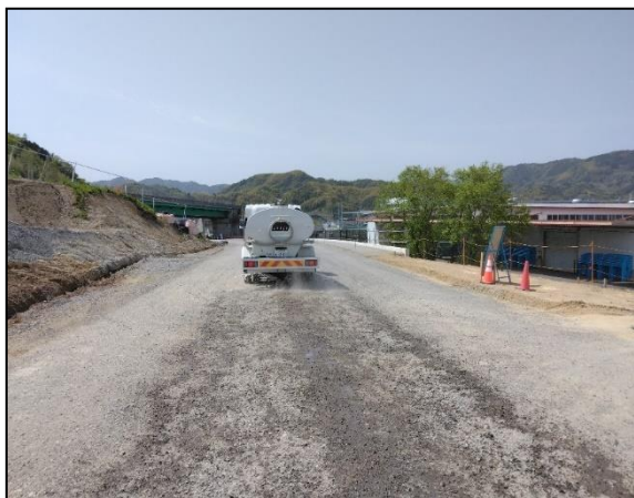
写真3 散水状況
