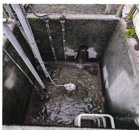
雨水排水路 集合樹 R2. 7. 31
