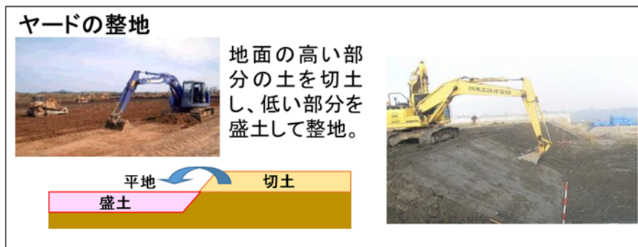
図 1-3(1) ヤード造成（写真は類似工事の例）
