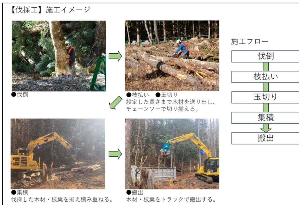
図 1-3 伐採（写真は静岡県内の宿舎等工事での事例）
