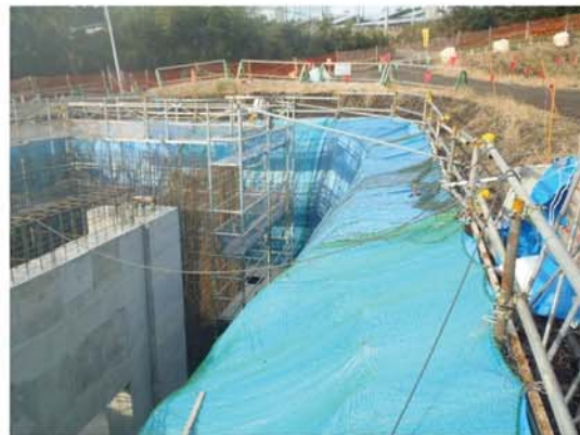
ビニールシートによる被覆
