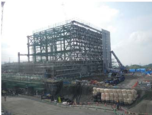
建築工事（工場棟）
