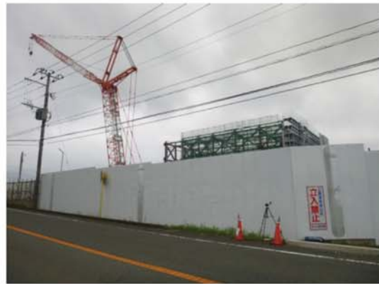
仮囲いの設置
