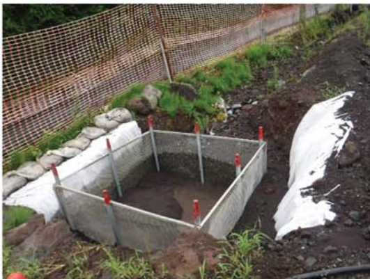
改変区域端部への雨水沈砂池と土嚢設置
