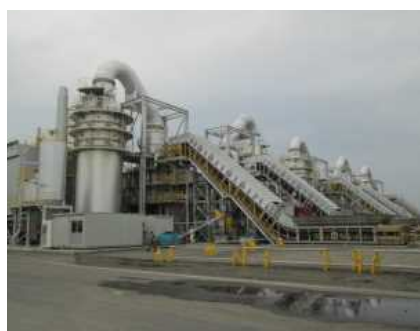
図7 仮設焼却施設(巨理処理区)
