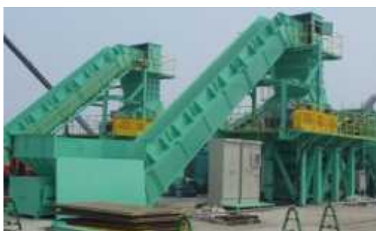
図6 破碎・細選別施設(巨理処理区)
