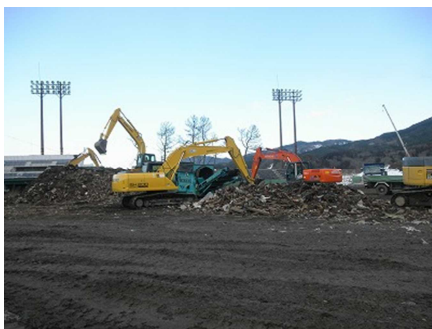
図4 重機による粗選別
