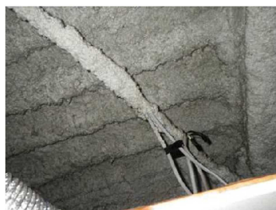
天井吹き付け材
