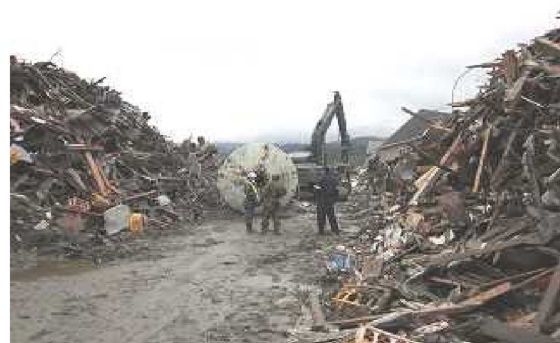
道路啓開：岩手県陸前高田市 出典：東北地方整備局
