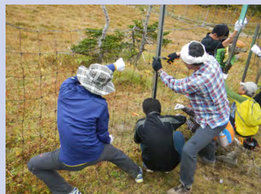
柵の補修（三伏峠）
