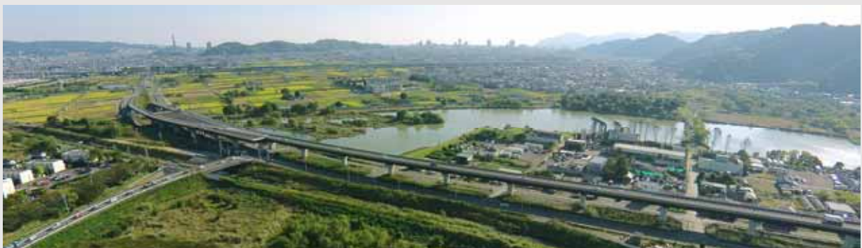
上空から見た麻機遊水地
