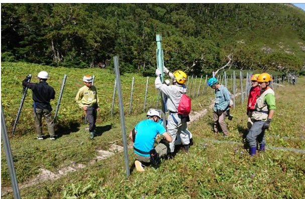
防鹿柵の設置作業(三伏峠)
