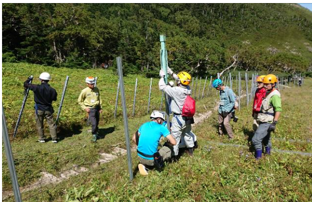
防鹿柵の設置作業(三伏峠)
