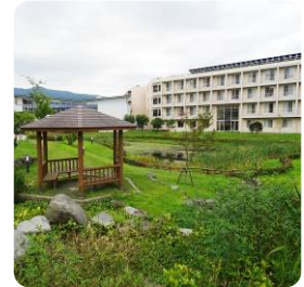
環境に配慮した宅地整備
