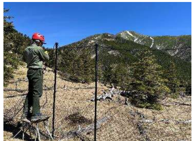
季節型樹脂製柵を立ち上げる作業 （レンジャーによる整備の様子）
