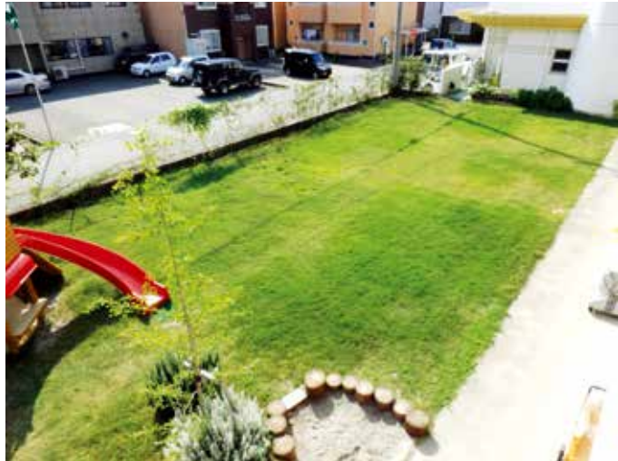
写真26 補修後の状態
