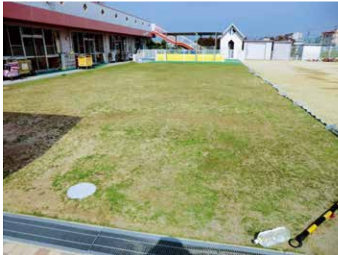
写真32 芝生がなくなった状態
