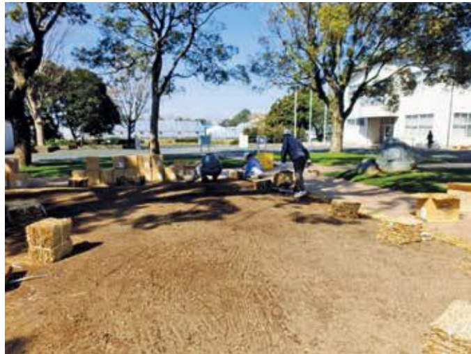
写真6 レーキで平に均した場所に端から順番にソッドを張っている 3月なので、芝生は休眠している
