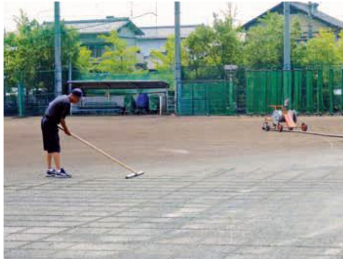
写真5 トンボに50 cm間隔で釘を打ち込み、それを引っ張ることで線を入れています
