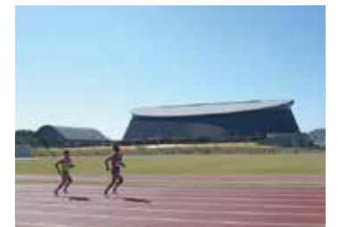
静岡県草薙総合運動場(静岡市)
