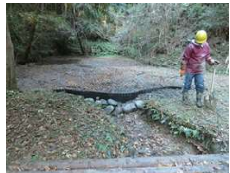
ため池流出口に波板を設置
