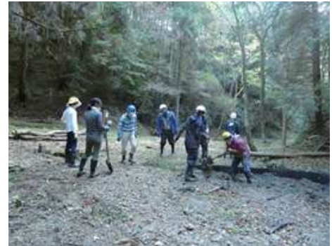
土砂流入で縮小したため池の土手再生
