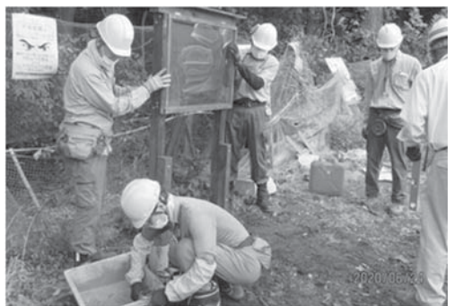
掲示板の設置作業
