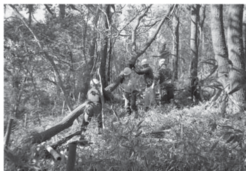
倒木の片付け作業(八雲神社裏山)
