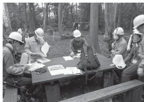
作業前のミーティング
