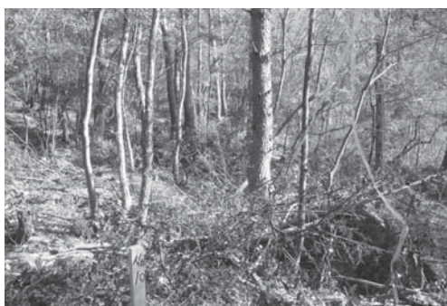
現場の状況（作業前）
