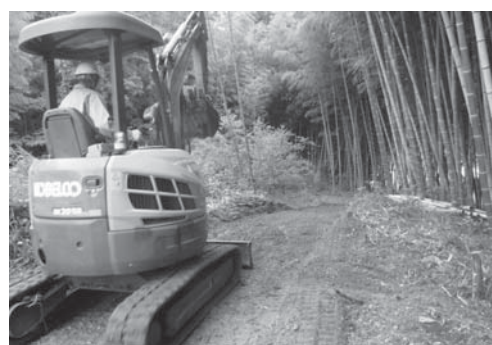
作業道の整備
