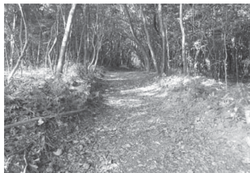
除伐、拡幅して整備した林内作業道
