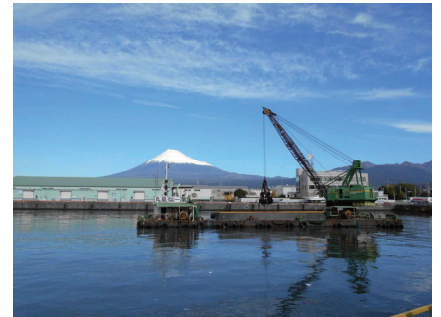
汚染底質の除去（浚渫）作業
