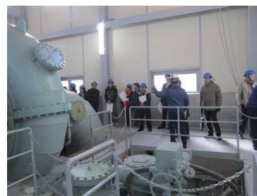
小水力発電所見学の様子
