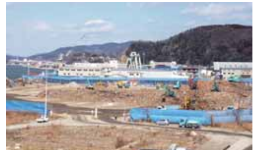
(処理前) 災害廃棄物が集積された仮置場
