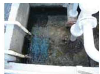
井戸内に設置した熱交換器 (青色の部分)
