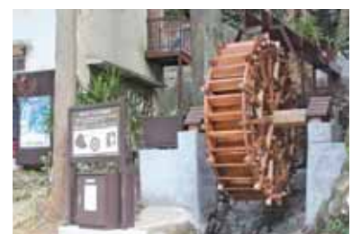
河津七滝小水力発電施設
