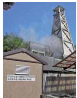
東伊豆町の温泉熱発電設備
