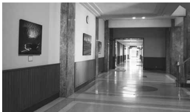
県庁本館に設置している伊豆、富士、安倍、大井、天竜の各産地のヒノキを使用した腰壁
