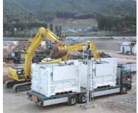
山田町での災害廃棄物積込作業
