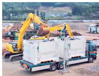
山田町での災害廃棄物積込作業
