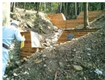
工事現場見学会 認定製品（木製残存型柵）を見学する技術職員
