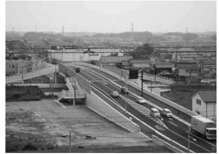
都市計画道路南上ノ原梅田線とJR東海道本線との立体交差化（湖西市）
