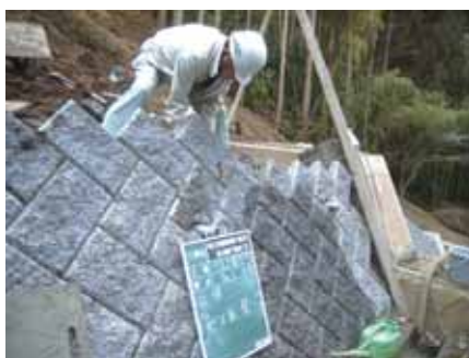
モデル工事（護岸工事） 認定製品（積みブロック）を使用
