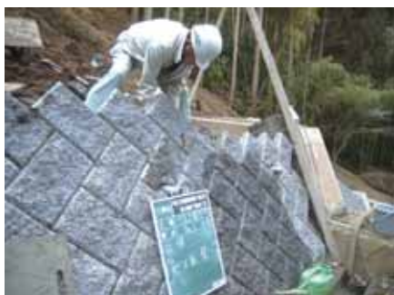
モデル工事（護岸工事） 認定製品（積みブロック）を使用
