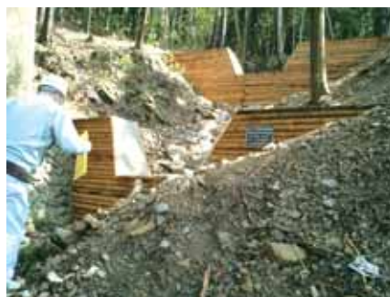
工事現場見学会 認定製品（木製残存型柵）を見学する技術職員
